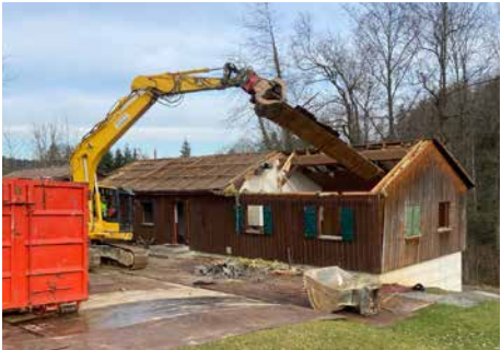
Der Abriss geht los
