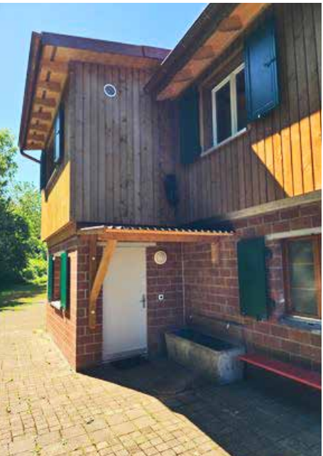
Aussenansicht unterer Eingang neu mit Überdachung
