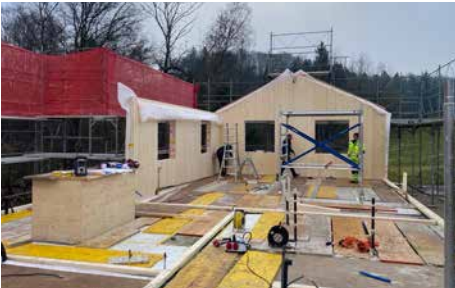
Die ersten Wände werden gestellt
