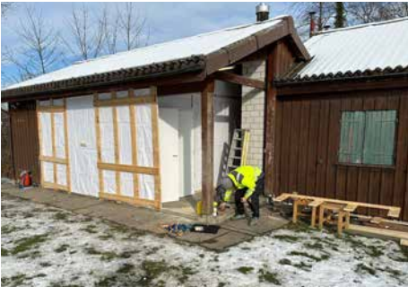
Provisorisches Lager und Werkstatt im Unterstand errichtet
