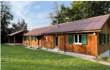
Westansicht Pfadiheim mit oberem Eingang
