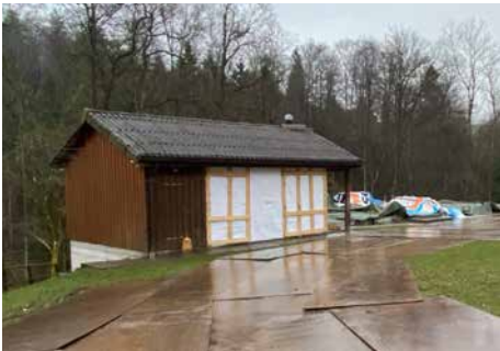
Es steht nur noch die Gartenhalle mit Lager und Materialschopf
