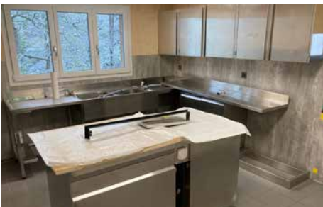
Wiedereinbau der bisherigen Küchengaritur
