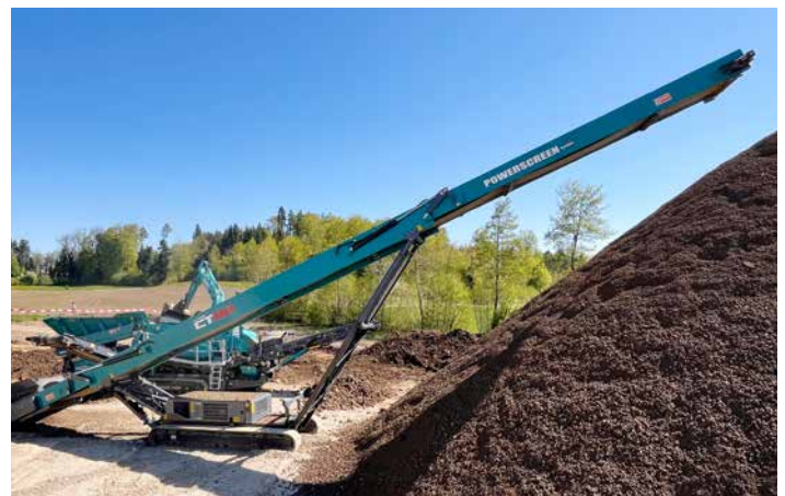
Der ausgehobene Oberboden wird gesiebt und wieder eingebaut
