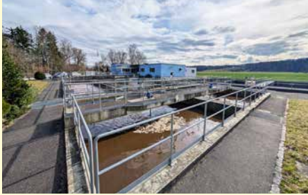
Betriebsbewilligungserneuerung der Kläranlage Mönchaltorf – S. 18
