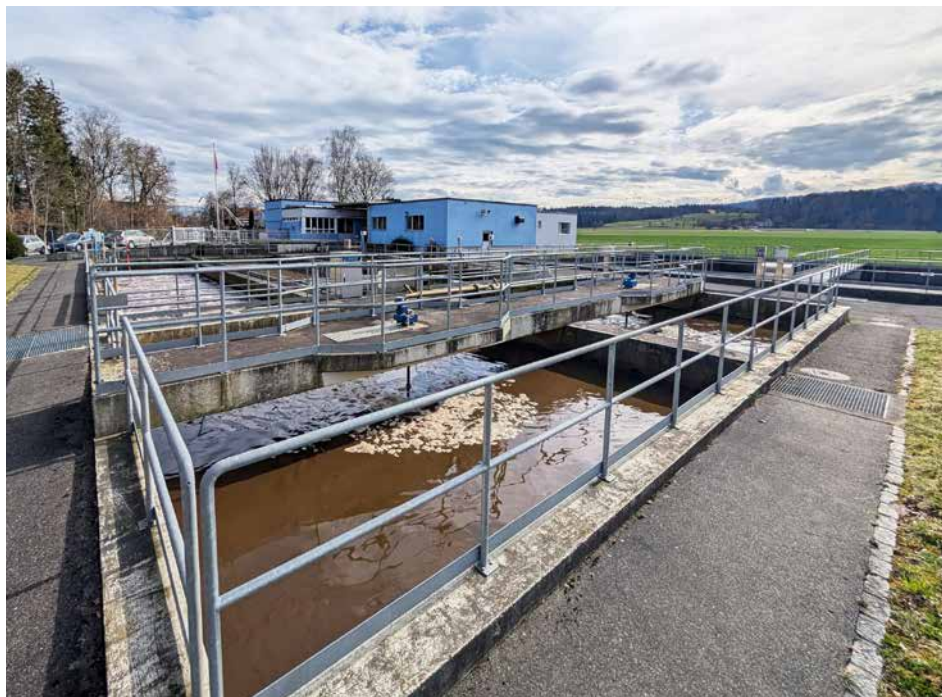
Blick auf das Filter- und Betriebsgebäude der ARA Mönchaltorf. Im Vordergrund die Biologie-Becken.
