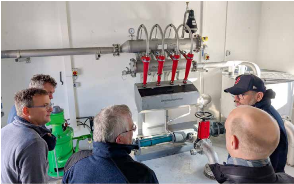
Besichtigung einer Hydrozyklon-Anlage zur Bildung von granulärem Schlamm durch eine Mönchaltorfer-Delegation aus Politik, Verwaltung und ARA-Mitarbeitern.
