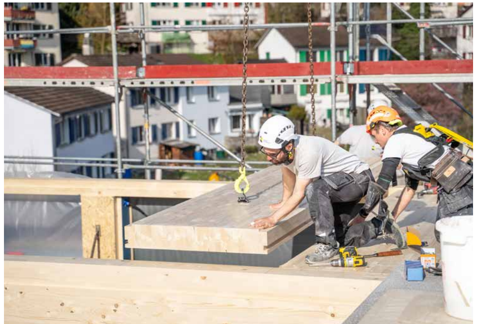
Sorgfältig montieren die Zimmerleute Stück für Stück die Deckenelemente
