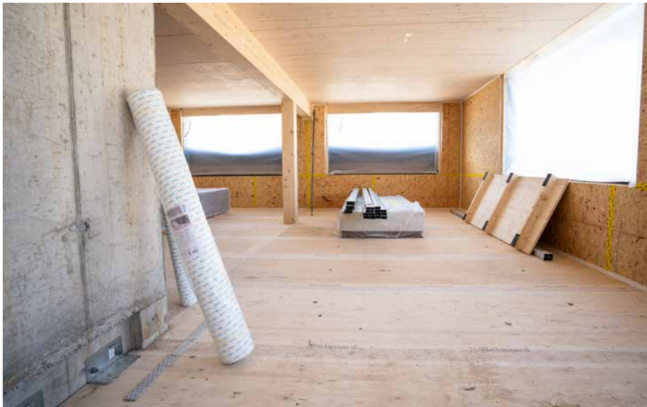
Ein erstes Raumgefühl wird spürbar, hier in einer Wohnung im dritten Geschoss des ersten Hauses
