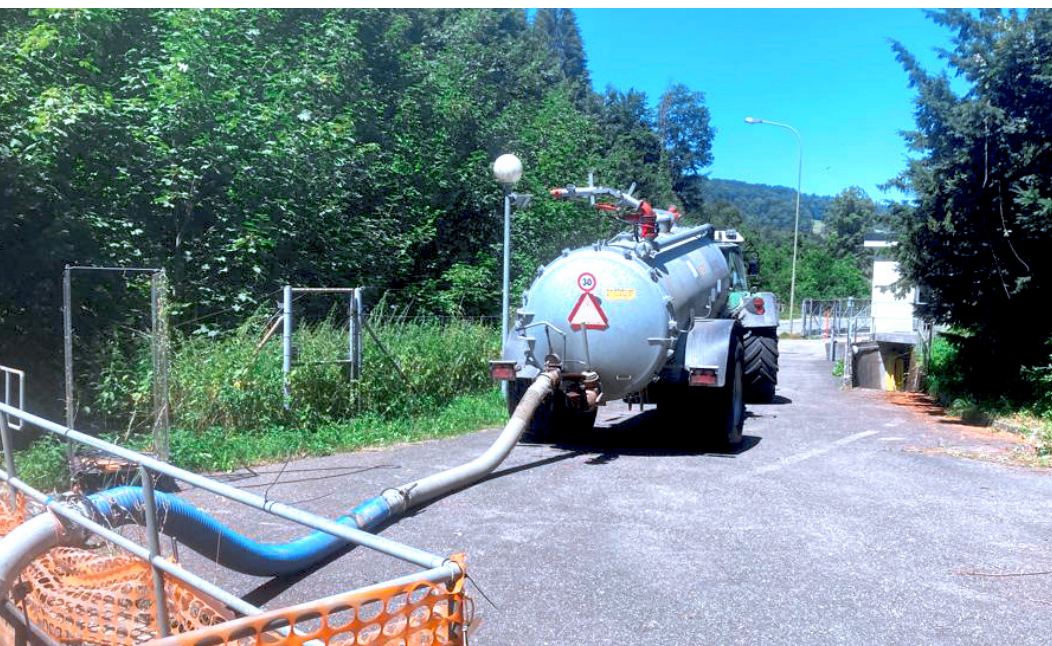
Regenwasser aus dem ehemaligen Klärbecken: In der stillgelegten ARA Unterdorf wurde eine leicht zu erreichende Wasser-Entnahmestelle eingerichtet. Im Notfall zählt jede Sekunde (zvg).
