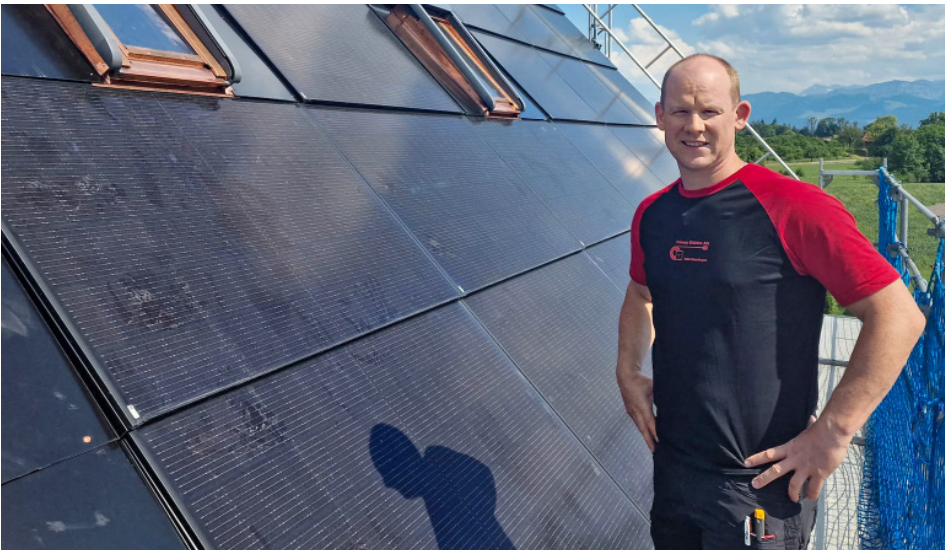
Stefan Bosshard von der Trümpy Elektro AG neben einer neu montierten PV-Anlage.
