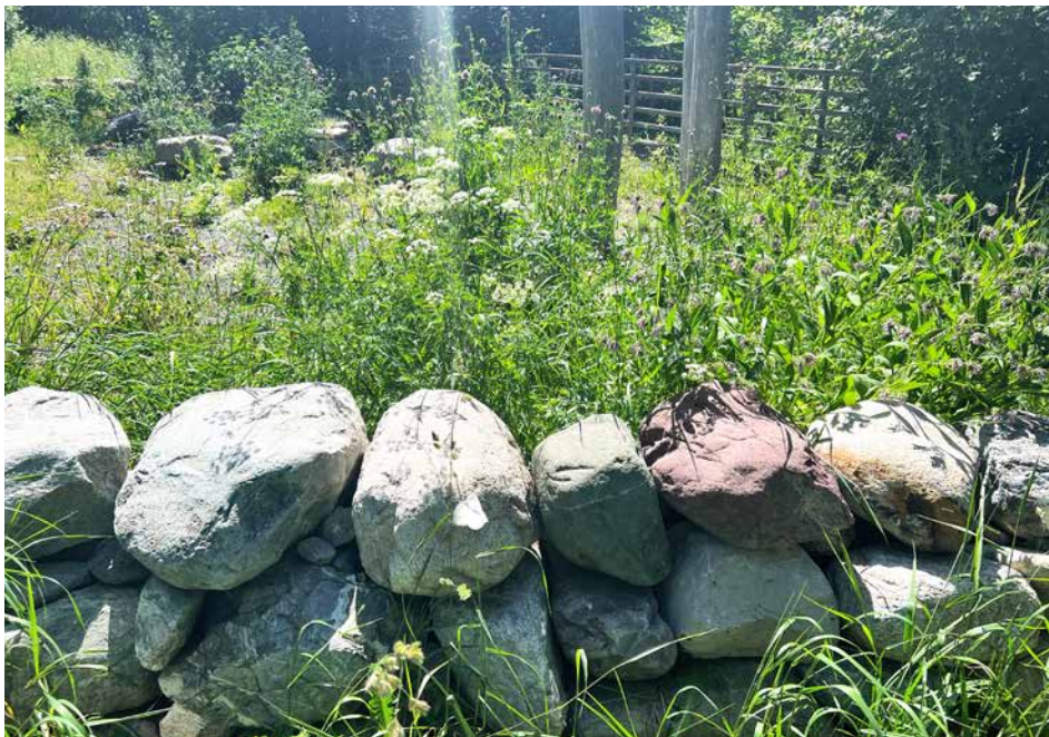
Trockenmauer und blühende Ruderalfläche
