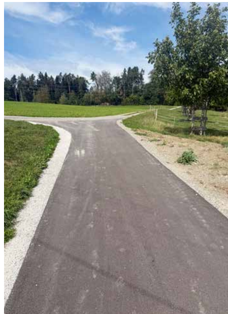
Die sanierte Berghaldenstrasse. Obwohl der neue Schwarzbelag in derselben Breite wie der ursprüngliche Belag eingebaut wurde, wirkt die Strasse optisch breiter. Dieser Eindruck entsteht durch das neu erstellte beziehungsweise angepasste Strassenbankett entlang des Fahrbahnrandes.
