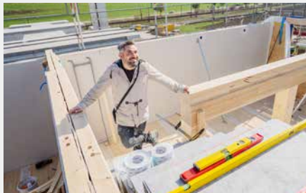
Baufortschritt bei den Riethöfen 14
